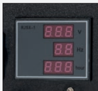
Display (tensão, frequência e contador de horas)
